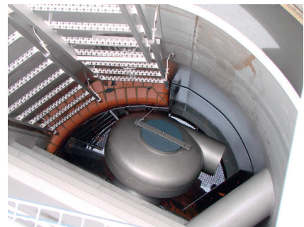
Bild oben: Der Eiserne Mönch in der Fertigung Bild Mitte: Der Eiserne Mönch montiert und verfüllt Bild unten: Wirbelventil in der vorderen Schachthälfte
