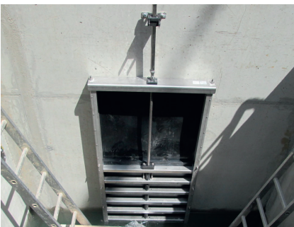
Bild: Absperrschieber bei Montage
