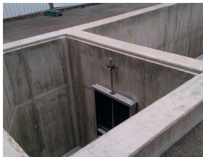
Bild: Absperrschieber DN 800 (rechts oben der Klärüberlauf)
