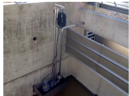
Bild oben: Absperschieber aus Edelstahl und PE Bild Mitte: Tauchwand-Überlauf-Garnitur Bild unten: Klarwasserpumpe und Tauchwand
