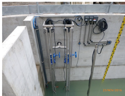
Bild: Entleerungspumpen inkl. Druckleitungen und Führungsrohren. Wasserstandsmessung und Elektro- installationen
