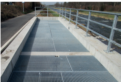
Das sehr schmale Bauwerk zwischen der B 31a und dem Fluss Dreisam; das Becken ist mit Gitterrosten abgedeckt
