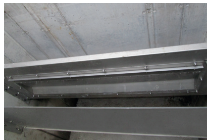
Selbstregulierender Klärüberlauf an der Beckenschmalseite
