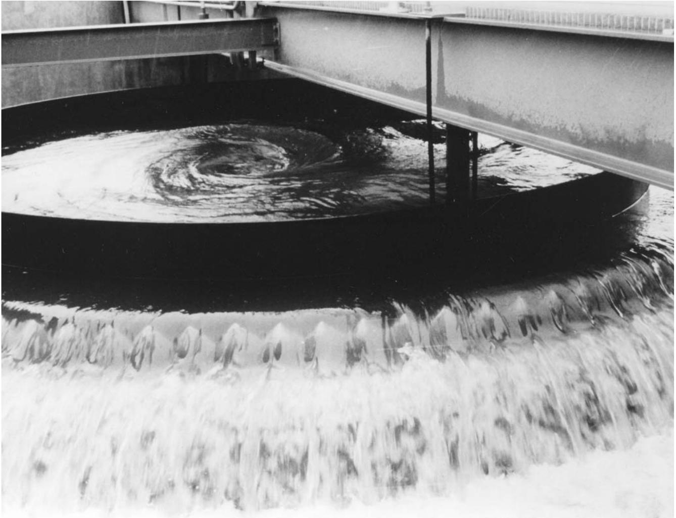
**Bild 3:** Wirbelabscheider in Aktion. Das überlaufende Wasser ist bereits relativ klar und wird im nächsten Prozessschritt desinfiziert.
