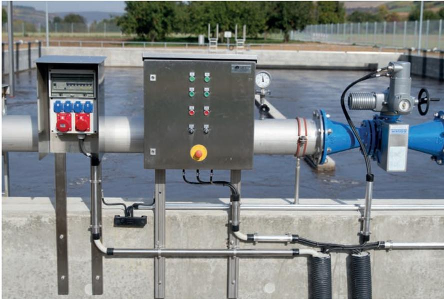
Belebungsbecken mit Steckdosenkombination, Vor-Ort-Steuerstellen sowie Blendenregulierungsschieber
