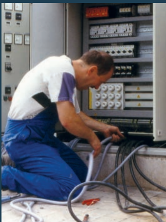
UFT-Elektromeister Gehringer bei der Arbeit
