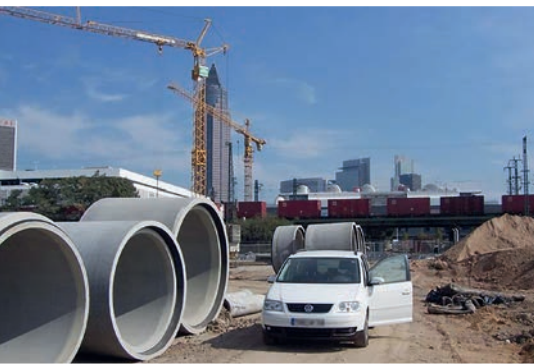
2006 wurde das Messegelände erweitert. Die großen Staukanäle warteten noch auf den Einbau.
