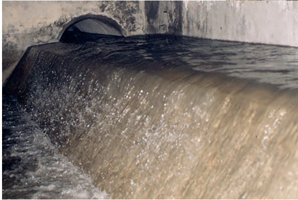
Überlaufereignis an einem Beckenüberlauf: Die Illustration oben zeigt eine Radarsonde, die den Wasserstand vor der Schwelle misst. Im Bild links eines der seltenen Fotodokumente von einem Überlaufereignis.
