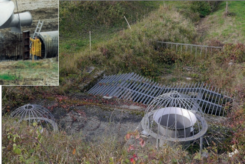
Einbau im Jahr 2002, Betrieb bis heute
