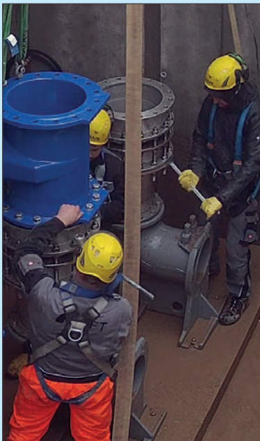
Die Abteilung ist heute gut gerüstet auch für große Montagen
