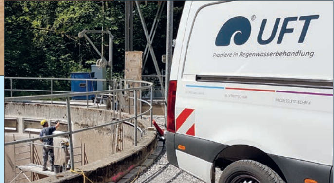
Montage von Selbstregulierenden Klärüberläufen im Jahr 2019 an Regenbecken in Fahrenbach und Schömburg
