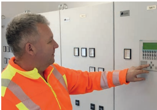
UFT-Schaltschränke für die Prozessleittechnik
