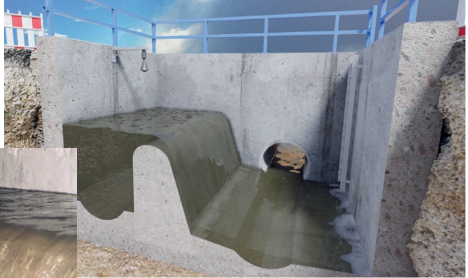
Überlaufereignis an einem Beckenüberlauf: Die Illustration oben zeigt eine Radarsonde, die den Wasserstand vor der Schwelle misst. Im Bild links eines der seltenen Fotodokumente von einem Überlaufereignis.
