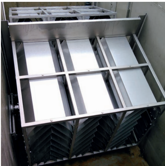
Testlauf eines UFT-FluidClear-X kurz vor Inbetriebnahme
