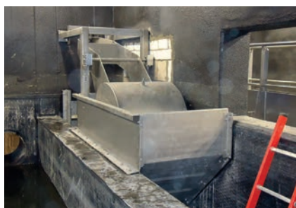
Läuft nach Plan: Der Kaskadenregler ist fast fertig eingebaut
