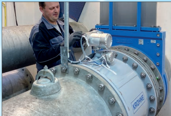
Inbetriebnahme durch UFT-Monteur an einem erst kürzlich erneuerten Messaufnehmer und Schieber in einer Bestandsanlage mit ungedükertem MID DN 700
