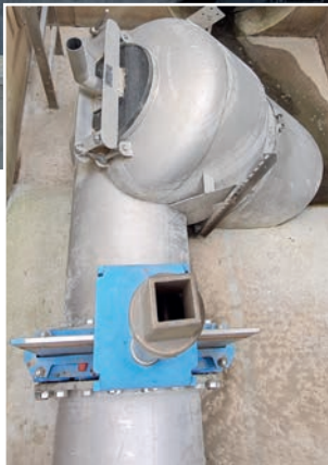
Blick auf ein Konisches Wirbelventil mit Schieber im Drosselschacht
