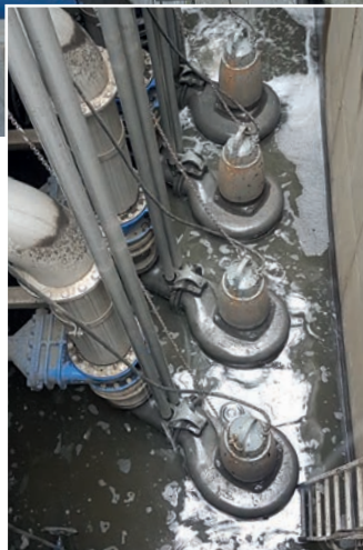
Das Pumpwerk am Regenklärbecken Böllinger Bach wurde von UFT geliefert und montiert
