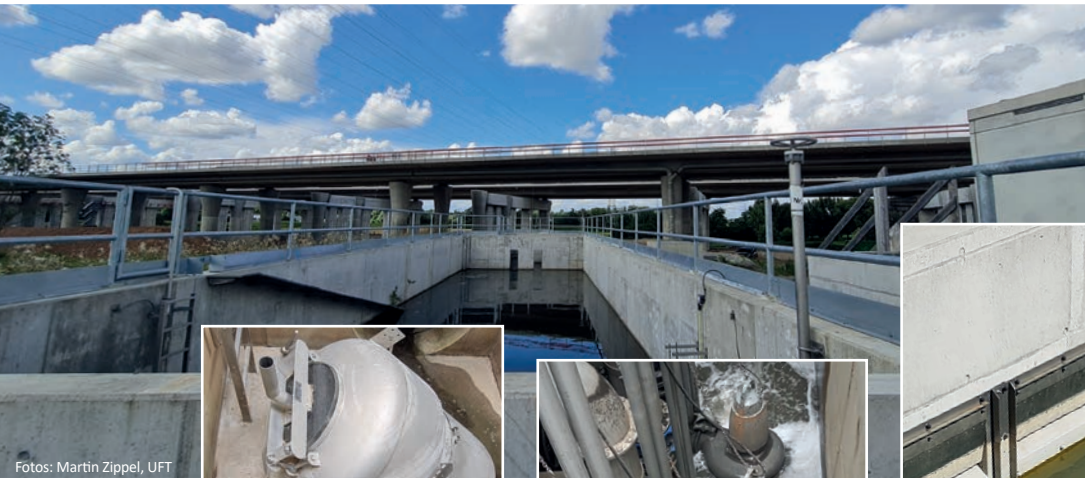
Blick auf das Regenklärbecken unweit der neuen Brücke über den Neckar an der BAB A6 bei Heilbronn
