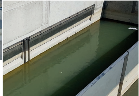
Selbstregulierende Klärüberläufe (links) von UFT und Tauchwände gehören ebenfalls zur Ausrüstung der Regenbecken an der A6
