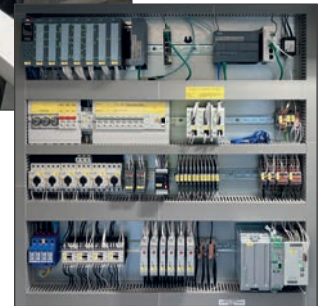
Übersichtliche Verdrahtung im Schaltschrank
