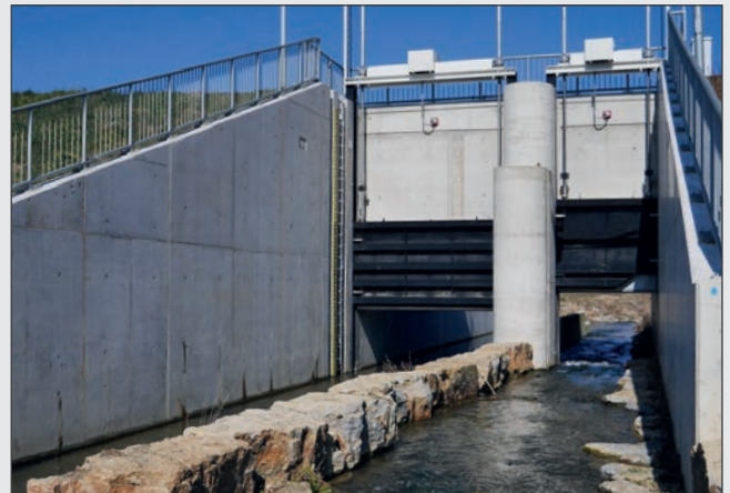
Das Bauwerk in Fließrichtung gesehen: beide Rollschütze sind in hochwasserfreien Zeiten komplett geöffnet
