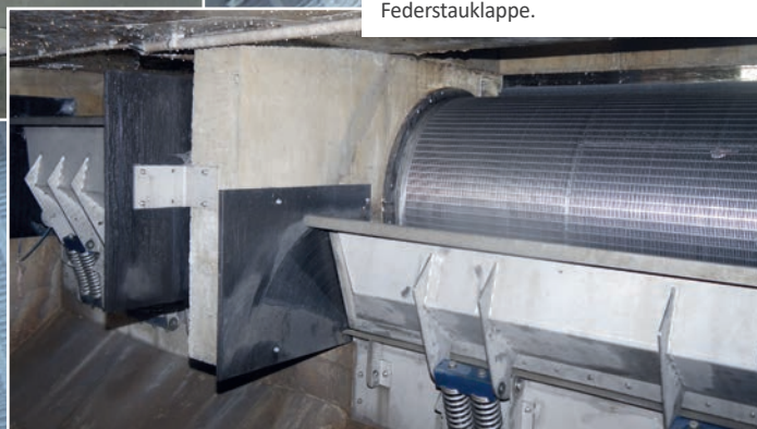
Trommeldrehfilteranlage von der Ablaufseite her gesehen. Hier ist eine Federstauklappe nachgeschaltet. Links ein etwas höher angeordneter Notüberlauf, gleichfalls mit Federstauklappe.
