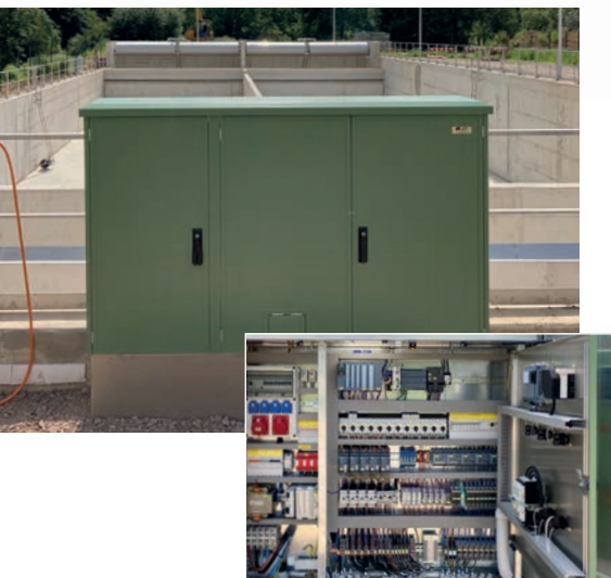
Großes Regenbecken in Bochum am Kirchhapener Bach mit Elektroausrüstung von UFT
