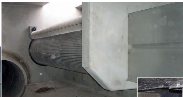
Nach der Installation vom Zulauf her gesehen. Rechts ein Notüberlauf mit Tauchwand.
