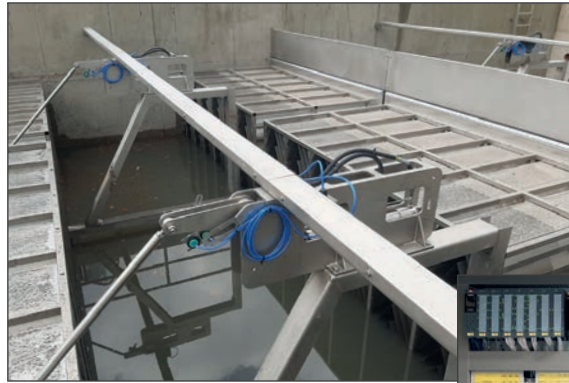
Hydraulische Schwenkantriebe für die automatisierte Reinigung der Lamellen
