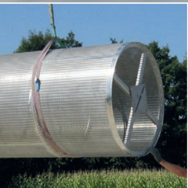
Einkranen der Filtertrommel
