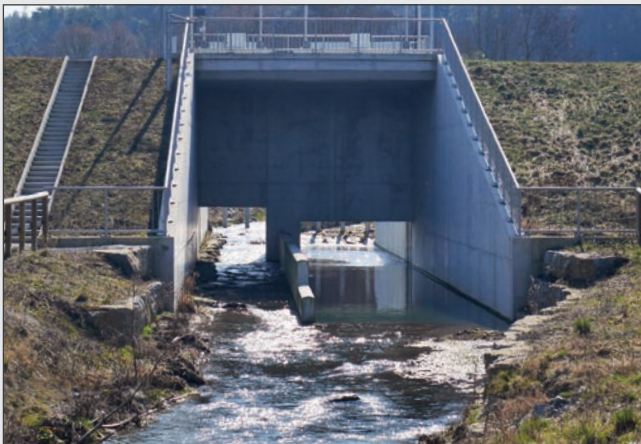
Blick auf das Auslassbauwerk gegen die Fließrichtung: links der Ökodurchlass, rechts der Betriebsauslass mit Tosbecken
