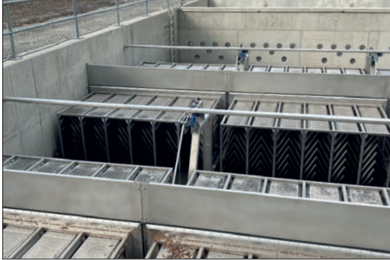
Blick in das große offene Regenklärbecken mit den Schrägklärer-Paketen
