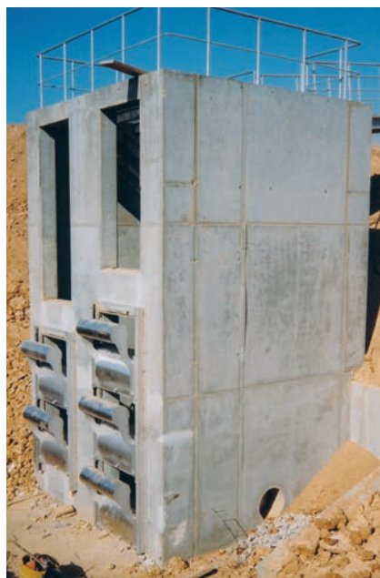
Das Wehr auf der Baustelle in Athen
