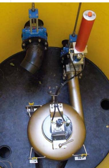
Blick von oben auf eine Turbo-Wirbeldrossel-Anlage in einem Drosselschacht aus PE. Der Ablauf aus dem Schacht ist am unteren Bildrand.
