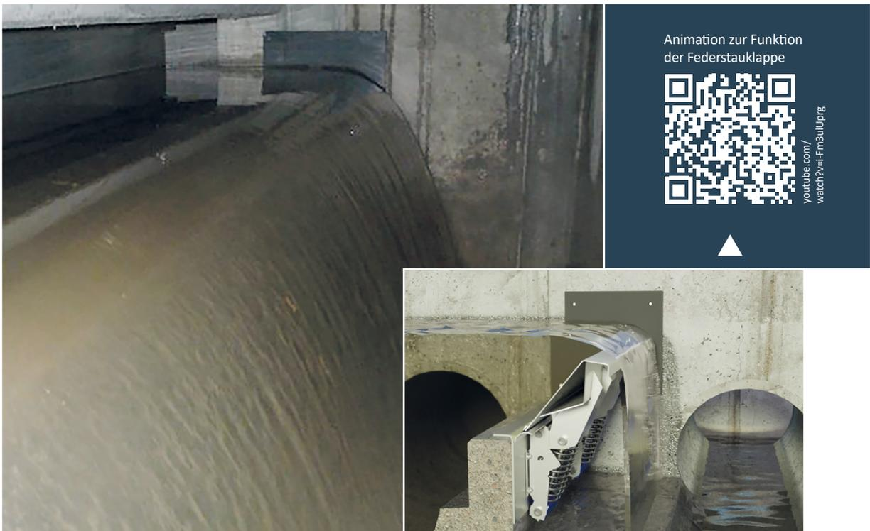
Durch die zusätzliche Messung von Wasserstand und Neigungswinkel können Entlastungsdauer und -häufigkeit sowie der Entlastungsabfluss ermittelt werden
