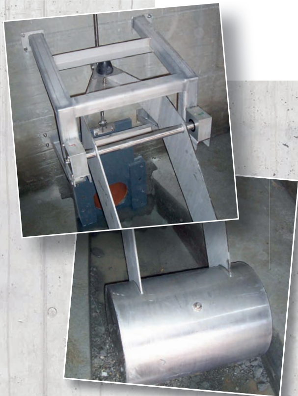
Wegen der Enge des Bauwerks aus zwei Aufnahmen zusammengesetzt: ein eingebauter Kaskadenregler, hier DN 200. Es sind Nennweiten bis zu DN 700 möglich.
