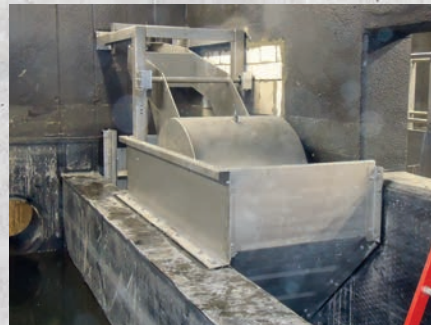
Kurz vor dem Ende der Montage 2011: einer von zwei UFT-Kaskadenreglern am Flughafen BER
