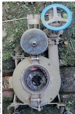
Die kleine Wirbeldrossel in einem Regenwasserspeicher auf dem Gelände der Max-Schmeling-Halle tut auch nach bald 30 Jahren weiterhin ihren Dienst
