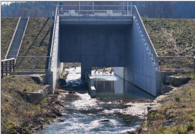
Das Bauwerk in Fließrichtung gesehen: beide Rollschütze sind in hochwasserfreien Zeiten komplett geöffnet
