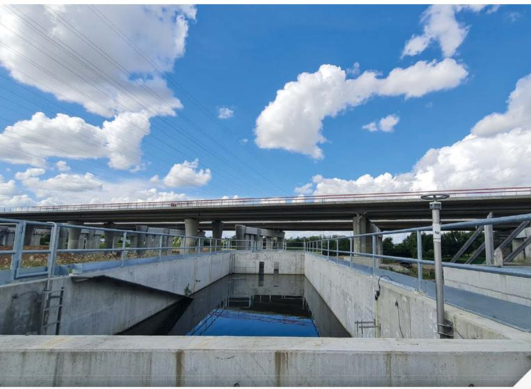
Mit der neuen Brücke wird auch gleich das Klärbecken für den Straßenablauf gebaut (am linken Beckenrand eine Amphibienausstiegshilfe)
