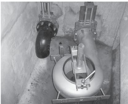
**Bild 5:** Drosselschacht mit einer Wirbel-drossel UFT-FluidVortex Typ HSU 3 DN 200. Bemessungsabfluss  $Q_b = 21$  l/s.
