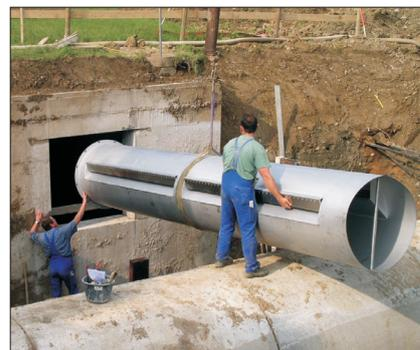
**Bild 6:** Der Klärüberlauf wird in ein bestehendes Bauwerk eingebracht Foto: UFT
