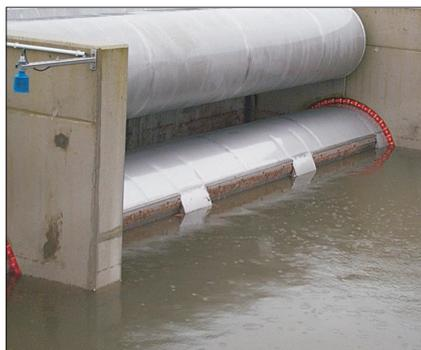
**Bild 5:** Selbstregulierender Klärüberlauf in Rohrausführung im Einsatz; Ansicht von außen (links) sowie Blick ins Innere (rechts) Fotos: Withopf
