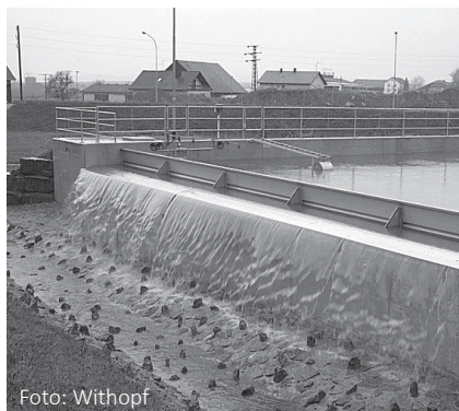
Bild 4: Überlaufereignis an einem Regenüberlaufbecken bei sehr kleiner Überfallhöhe. Über dem Wehrrücken fließt das Wasser in einem dünnen Film ab.
