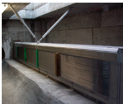
Bild 2: Feinrechen Typ RSW 4x4/4, Blick auf die Zulaufseite
