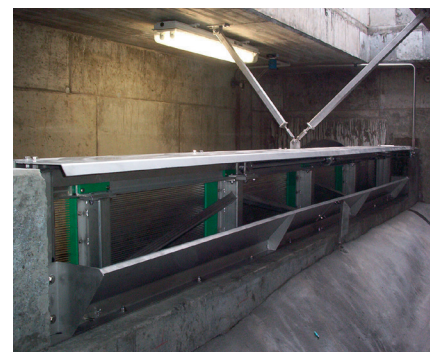
Bild 3: Feinrechen Typ RSW 4x4/4, Blick auf die Ablaufseite mit dem Staublech
