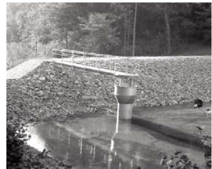
Bild 2: „Eiserner Mönch“ kurz nach der Montage in dem Vorbecken einer Talsperre. Das Becken wird inzwischen bis knapp über die konische Aufweitung eingestaut.
