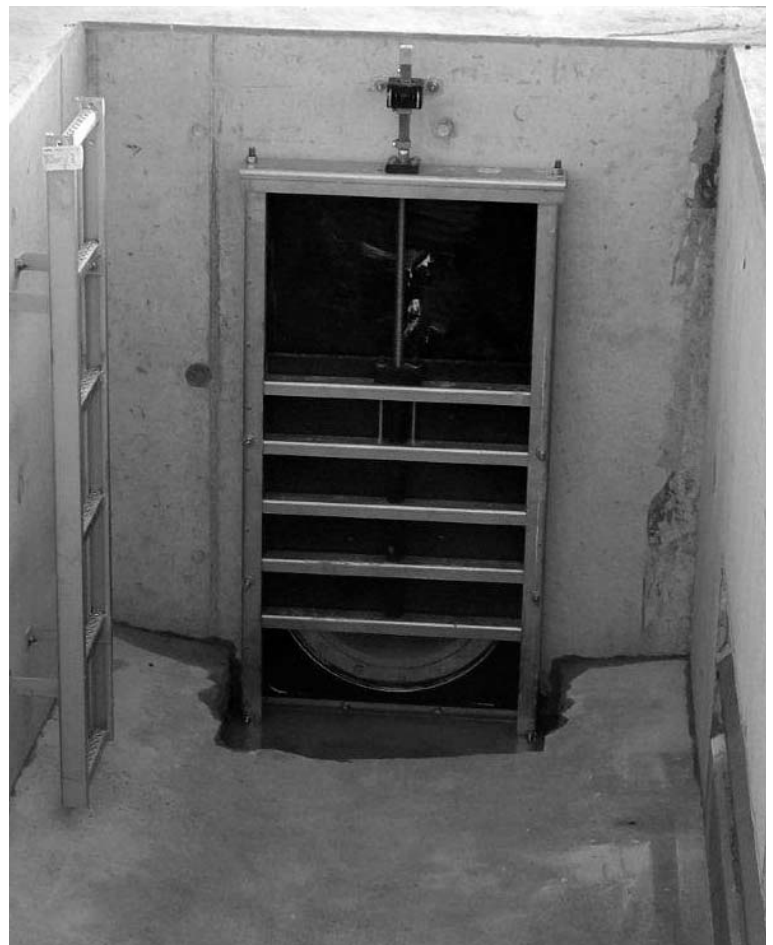
Bild 2: Absperrschieber UFT-FluidKWT DN 500 am Ablauf eines Regenklärbeckens unmittelbar nach der Montage
