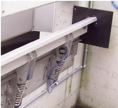
Bild 5: Neigungswinkelsensor an einer Federstauklappe
