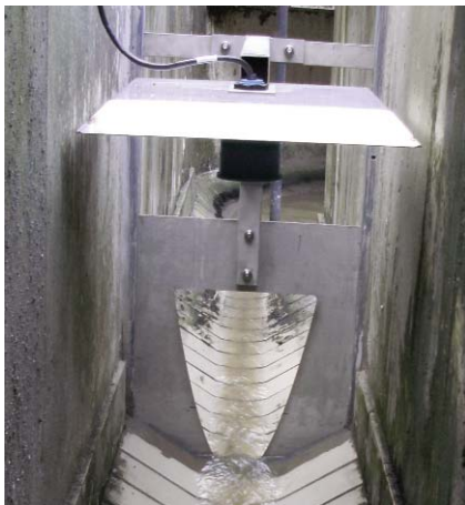
Bild 2: Parabelmessblende DN 200 mit Ultraschallsonde. Die Sonde für die Wasserstandsmessung ist an der Messblende befestigt und mit einem Schutzdach abgedeckt.
