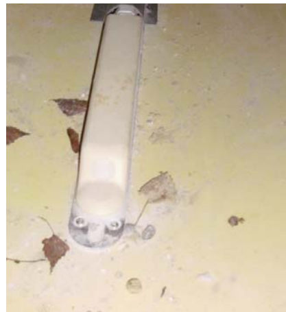
Bild 3: Eine so genannte „Kanalmaus“, eingebaut auf der Sohle einer Entlastungsleitung
