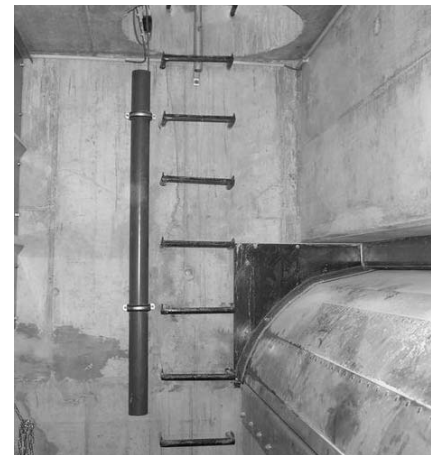
Bild 4: Hydrostatische Drucksonde im Schutzrohr vor einer beweglichen Schwelle (Biegeklappe)
