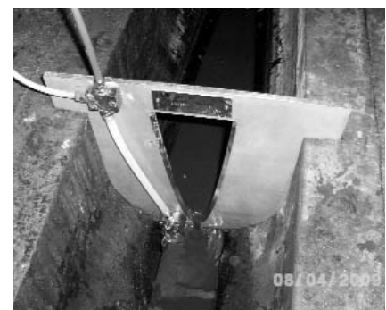
Bild 4: Abflussmessung mit Venturi-Blende
