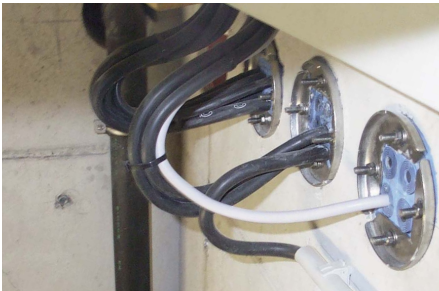
Bild 4: Wasserdichte Durchführung, Fabrikat Roxeltec
