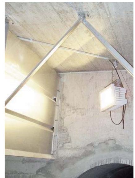
Bild 5: Ex-geschützter, drehbar gelagerter Strahler im Regenbecken
