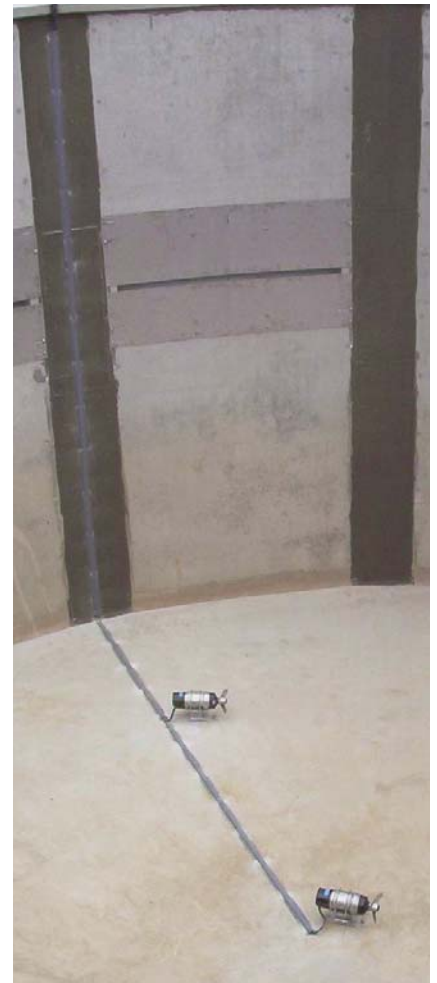
Bild 3: Halbschalen zum Schutz der Rührwerkskabel
