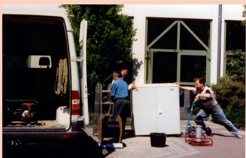
**Bild 1:** Der Schaltschrank wurde im Werk verdrahtet und getestet. Er wird nun verladen.
