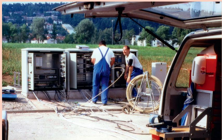
**Bild 3:** Die Schaltschränke sind aufgestellt und werden jetzt angeschlossen.
