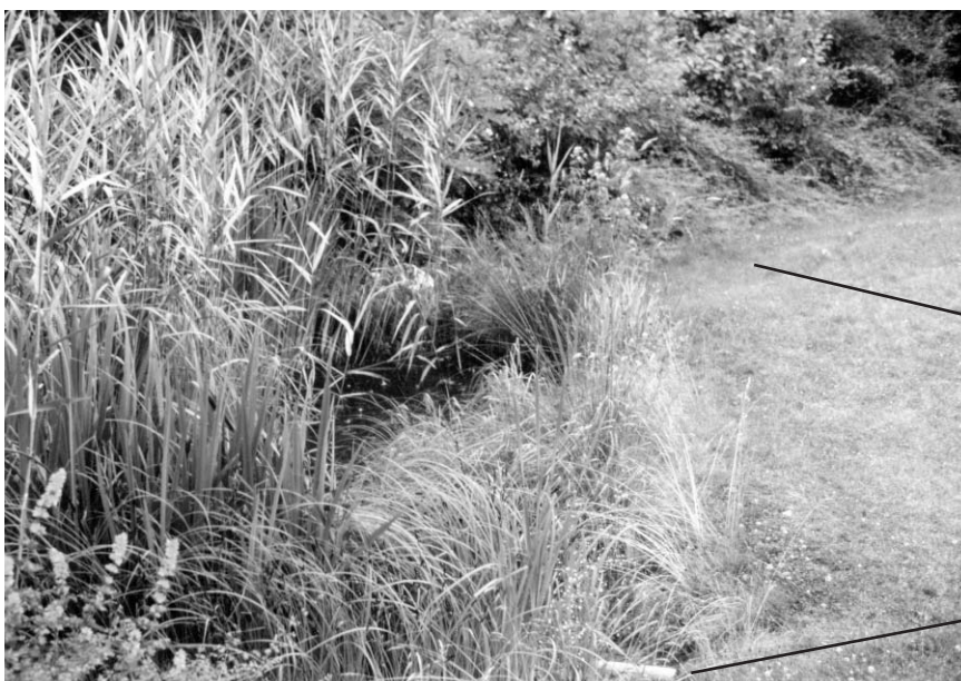
Bild 2: Teich mit nachgeschalteten Versickerungsmulden nach den ersten zwölf Betriebsjahren
