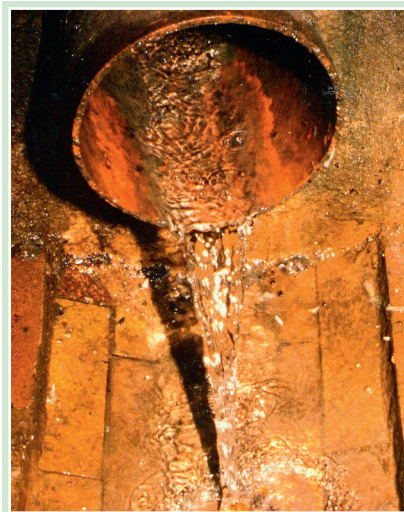
Bild 1: Glasklarer permanenter Zufluss aus einem Drainagerohr – ein sicheres Indiz für Fremdwasser
